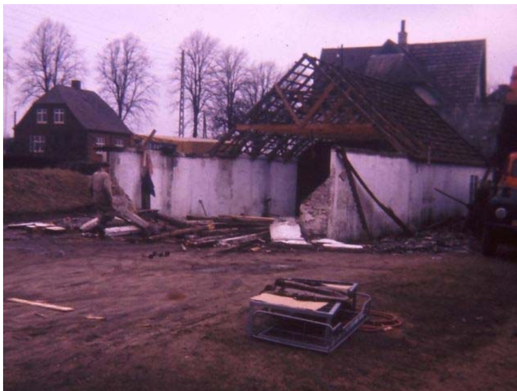
Nedrivningen er i gang
