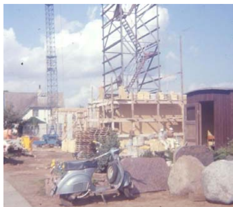
Tårnet er rejst og murerarbejdet er begyndt
