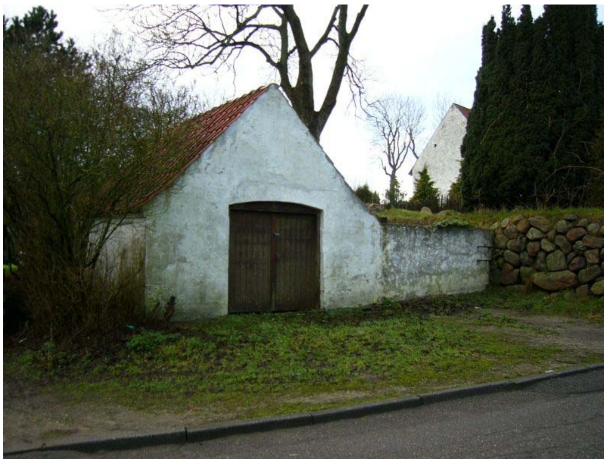
Sprøjtehuset i Torrild
