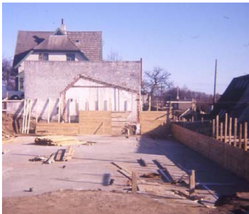
Den første forskalling er sat.
