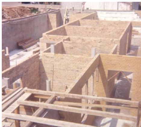
Kælderskillerum er muret op.
